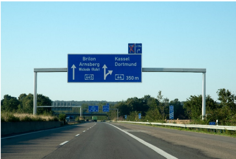
Abbildung 1 - Wegweiser vor dem Autobahnkreuz Werl
