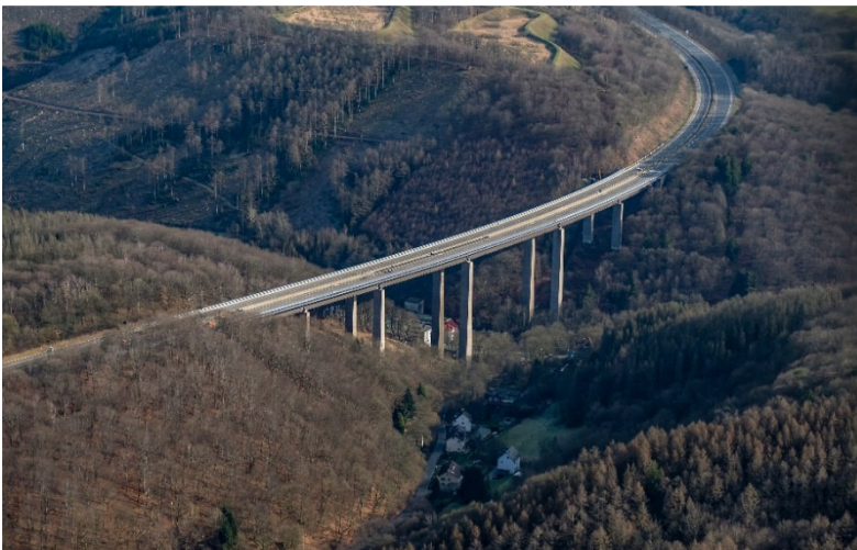
Abbildung 6 - Die stillgelegte Rahmedetalbrücke an der A 45
